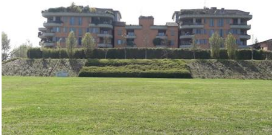
Figura 13 - Veduta dall'Impianto verso il lato Sud
