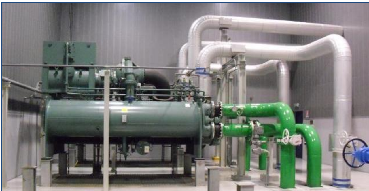
Figura 5 - Frigorifero a compressione
